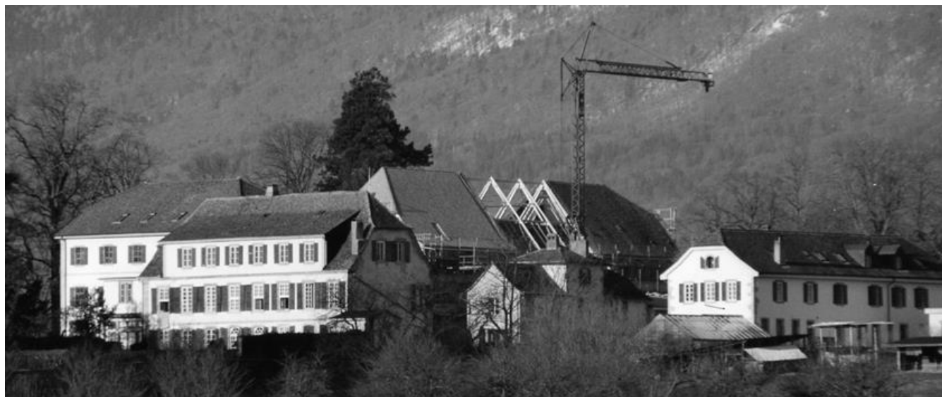
Das Gästehaus während einer umfassenden Renovation im Jahr 2000
