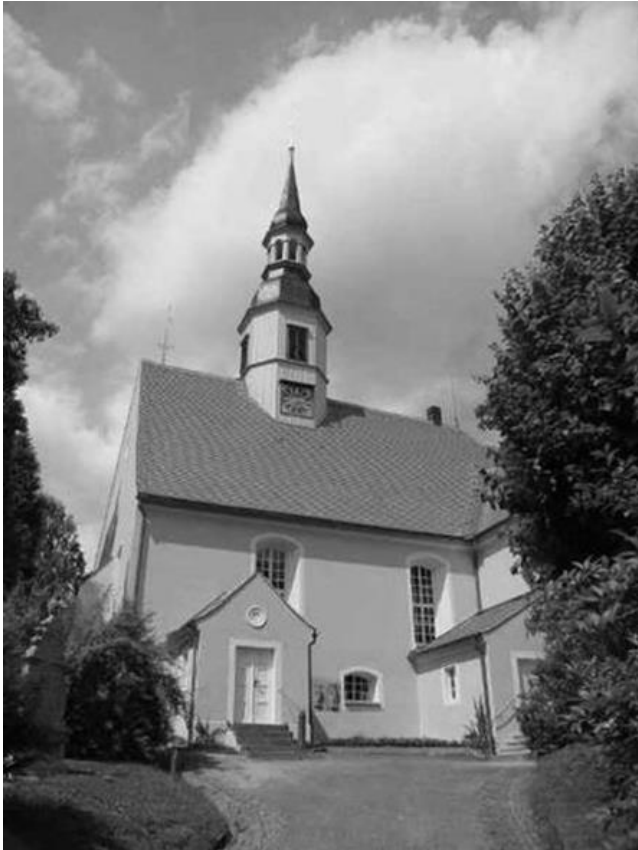
Die lutherische Kirche in Berthelsdorf
